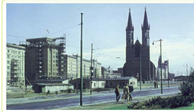
50er Jahre – die neue Innenstadt entsteht im Ensemble mit der Ulrichskirche
